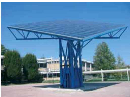
Provincia di Forlì - scuola Matteucci Programma Tetti Fotovoltaici "Bando Nazionale"
