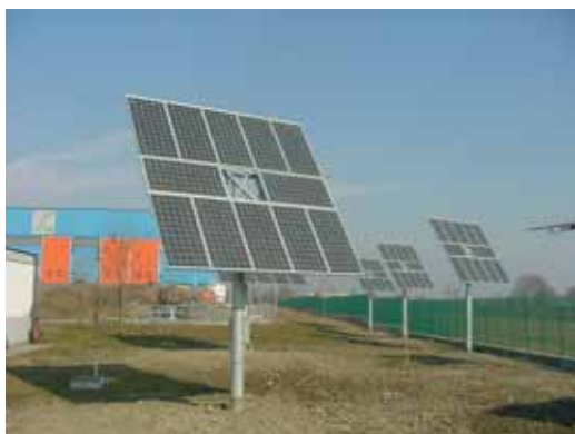
AMIAT Torino - impianto di compostaggio Programma Tetti Fotovoltaici "Bando Nazionale"
